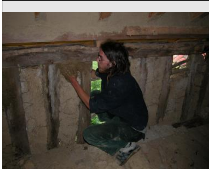
Remplissage des colombages avec les briques. Lissage de la surface de terre.
