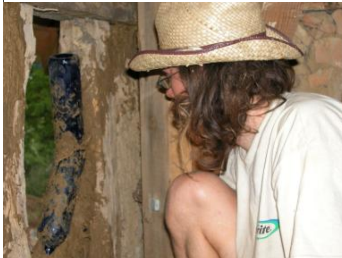
Remplissage des colombages avec des bouteilles.
