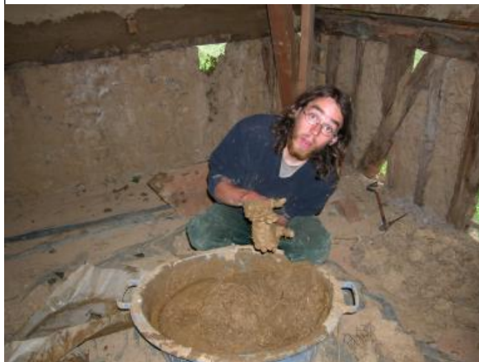
Pétrissage et façonnage des briques à mains nues (éliminer l'air, rabattre les brins de paille, faciliter la pose).
