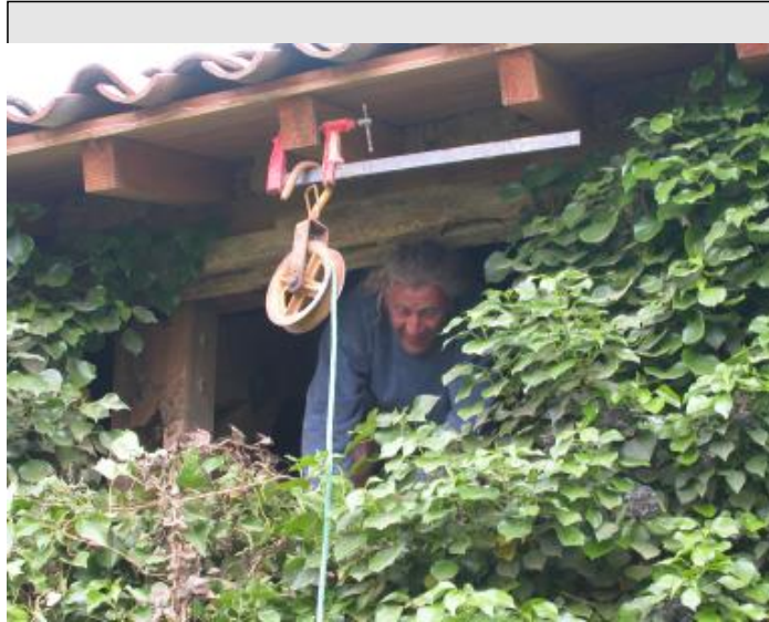
Elevage de la terre par poulissage.
