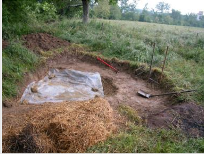
Trempage pendant trois heures, protéger avec une bâche pour éviter l'évaporation.
