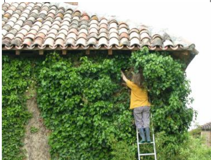
A l'extérieur, enlèvement du lierre.
